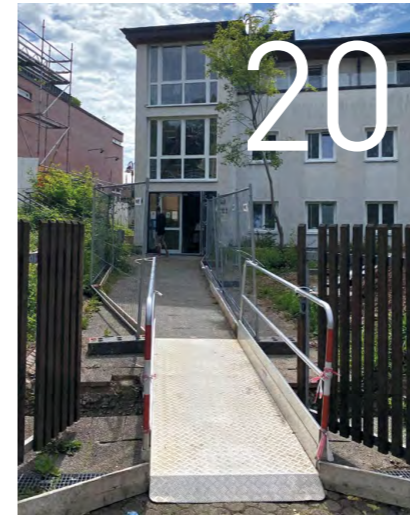
Baustelle, barrierefrei. Auch für blinde Menschen.
