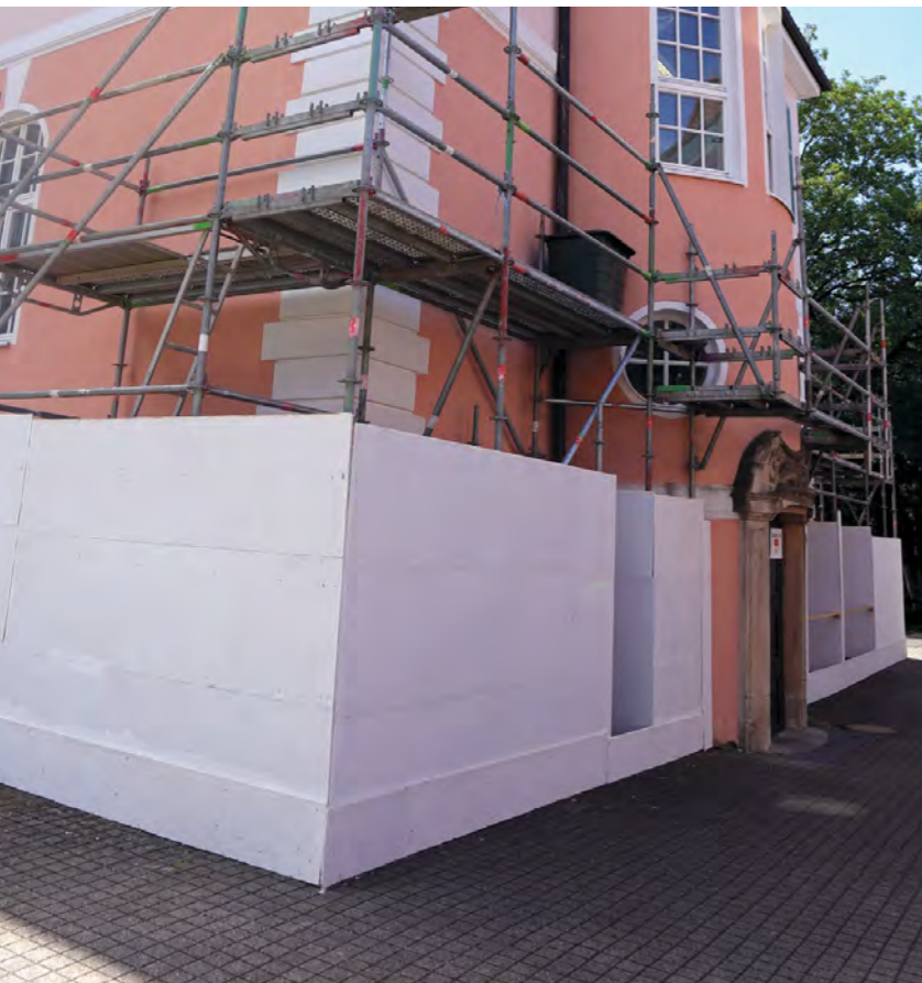
Damit blinde und sehbehinderte Menschen sicher durch die Baustelle kommen, sind alle Bauzäune barrierefrei mit Tastkanten ausgestattet.
